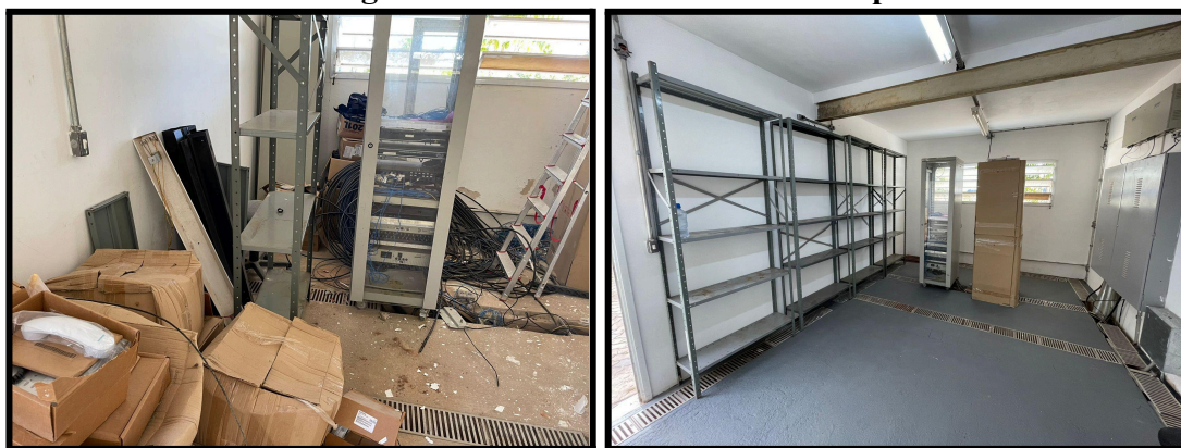
Figura 2 - Sala do telecom antes e depois
